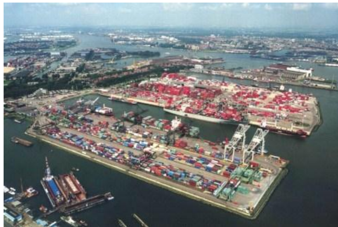
Fotografía 2.2: Vista lateral del Puerto de Rotterdam
