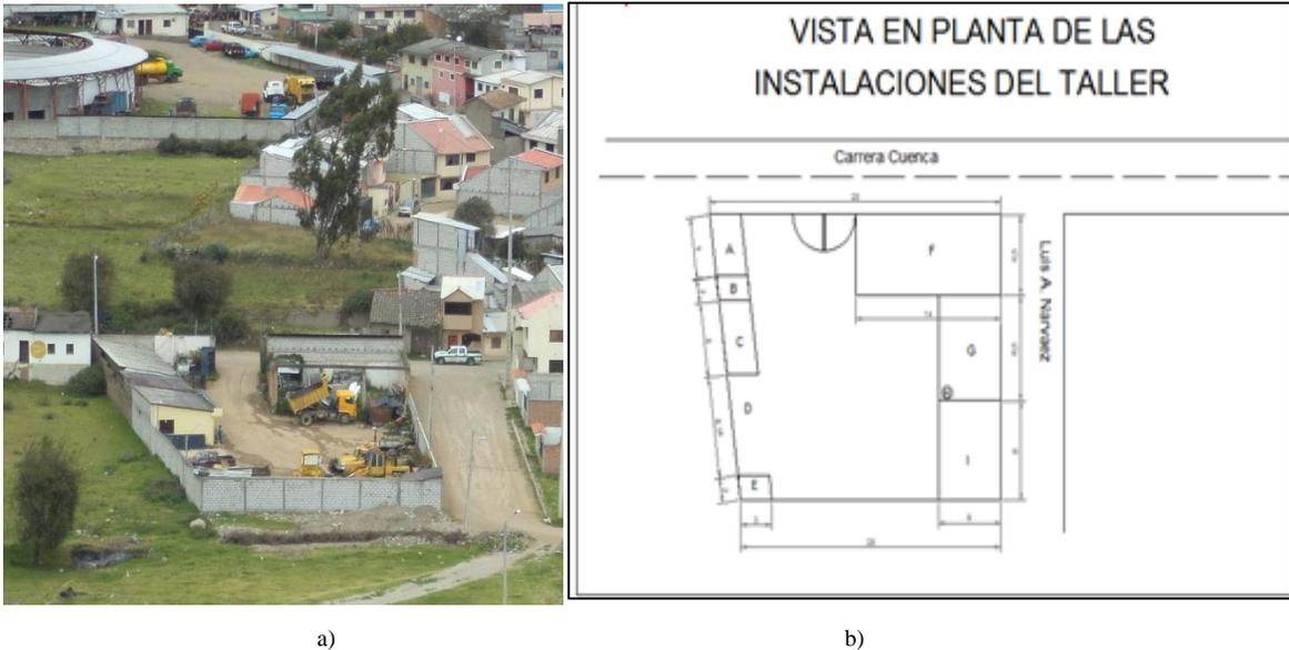
La infraestructura del taller es totalmente inadecuada, debido a que no ofrece las comodidades suficientes a los operarios para realizar el mantenimiento, como es rampas para un mejor desenvolvimiento del personal a cargo del trabajo, no cuenta con una cubierta en las zonas de trabajo exponiéndolos al sol y a la lluvia, como también, no tiene una superficie solida de asfalto. Figura 2 hasta Figura 4.
