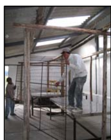
Fotografía 14. Adecuación del invernadero.
