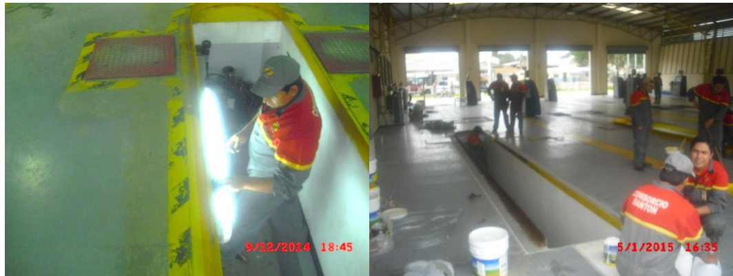
Figura 93. Pintura de interior de instalaciones.
