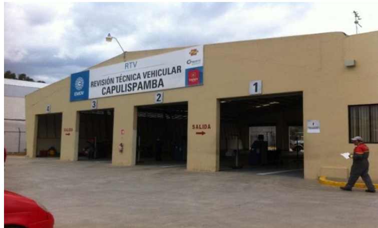
Figura 17. Centro de inspección técnica vehicular de Capulispamba.
