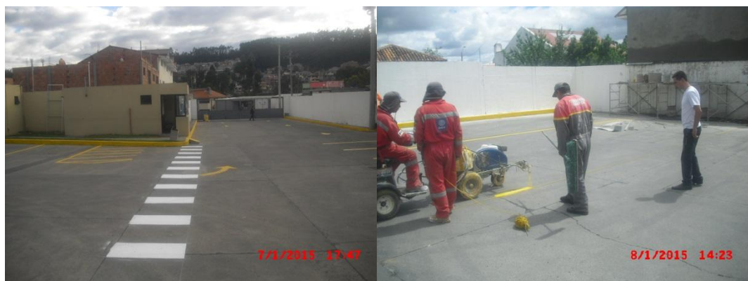
Figura 94. Pintura de exterior de instalaciones.
