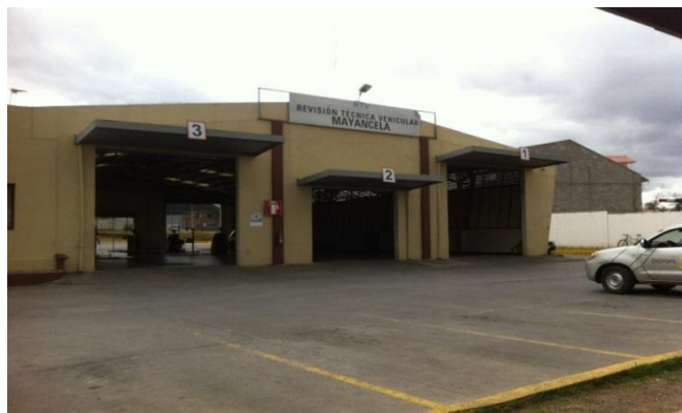
Figura 16. Centro de inspección técnica vehicular de Mayancela.
