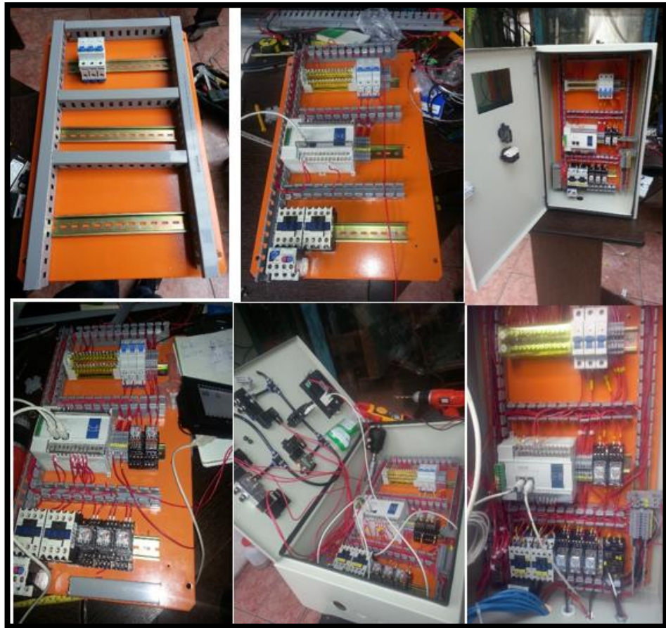
Figura 5. 7. Proceso de ensamblaje del centro de control.
