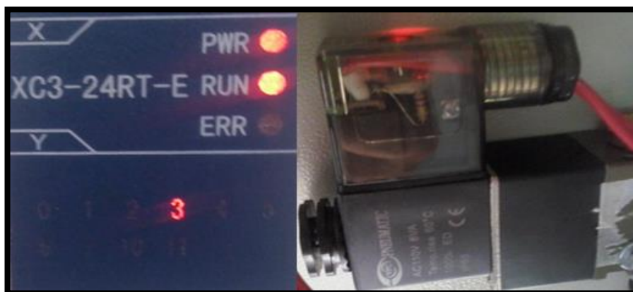
Figura 5. 24. Señal de salida válvula de paso de pintura.
