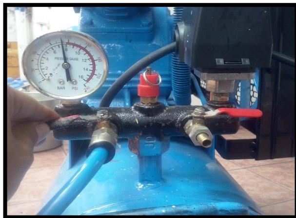
Figura 5. 33. Verificación funcionamiento compresor.
