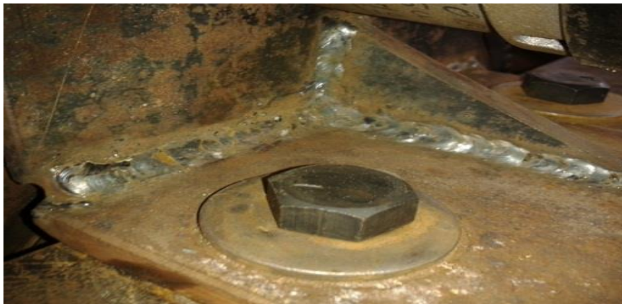
Fig. 3.4. Pernos de unión de la placa soporte, cordón de soldadura
