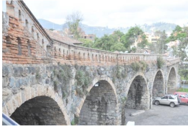
Figura 2: Puente con mampostería de piedra, Cuenca-Ecuador.
