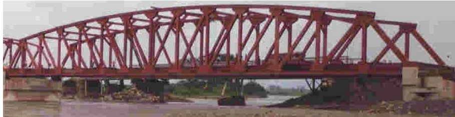
Figura 4: Puente celosía metálica sobre el río San Pablo – Guayas.
