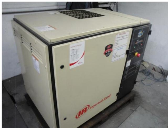
Figura 2.27. Compresor general de la planta
