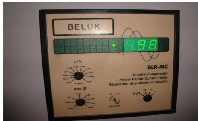
Figura 2.28. Controlador de factor de potencia existente
