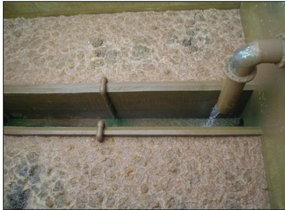
Fig. 1.11 Proceso de Retrolavado de los Filtros
