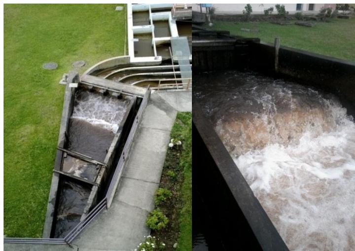
Fig. 1.5 Canal de mezcla rápida y coagulación.
