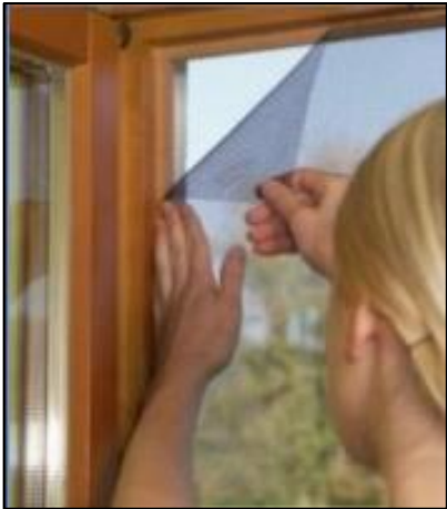
Figura 12. Ventana con lámina protectora.
