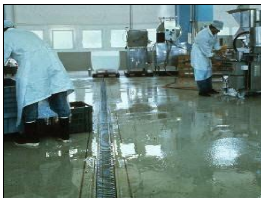
Figura 10. Piso en Planta de Alimentos
