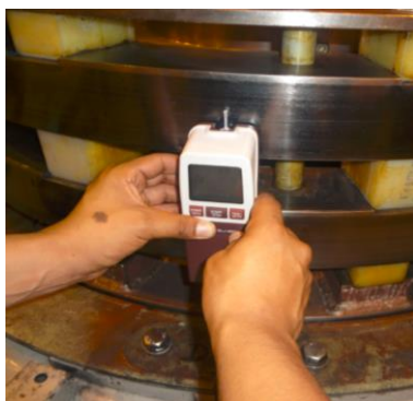
Ilustración 44. Medición de rugosidad en los anillos colectores (Ing. Mec. Fabricio Gallardo)
