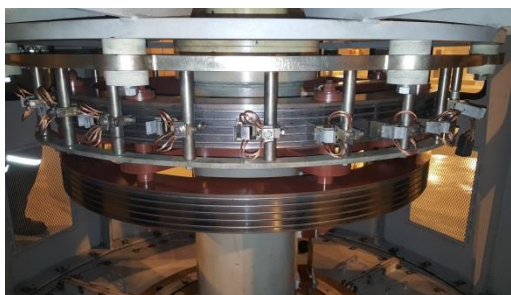
Ilustración 3. Sistema de escobillas-anillos generador síncrono ALSTOM (Fuente propia)
