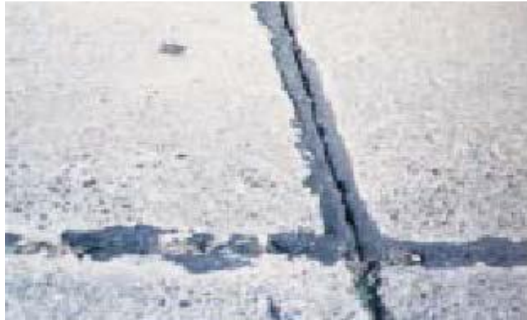
Extrusión del material de sello
