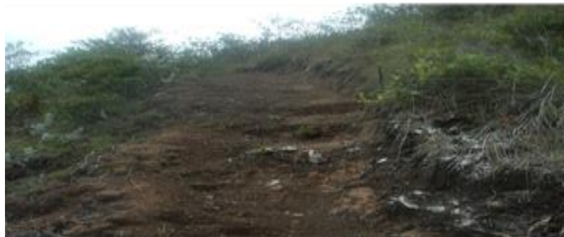
Fotografía 23: Adecuación del Sendero.
