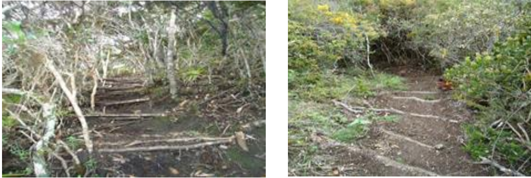
Fotografías 26 y 27: Construcción de Gradadas.
