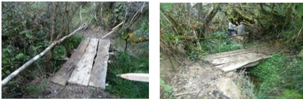
Fotografías 24 y 25: Construcción de Pasamanos y Puentes.
