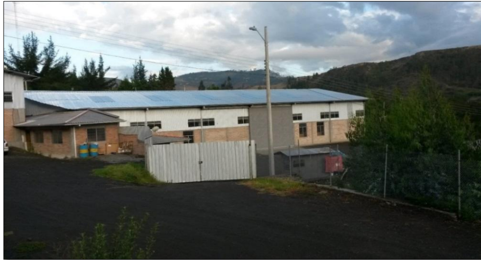
Fig. 2.10 Bodegas destinadas al almacenaje de repuestos automotrices.
