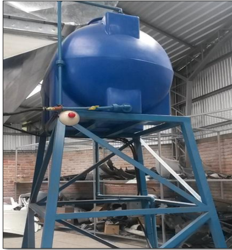
Fig. 3.21 Tanque de reserva diésel para la cabina Conquer.
