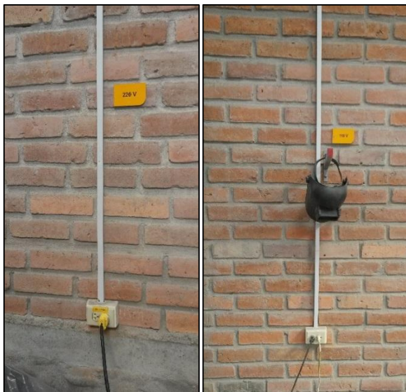
Fig. 3.4 Toma corrientes de 110 y 220 V
