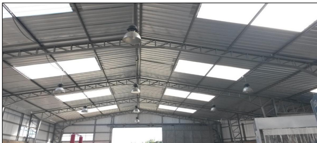
Fig. 3.11 Lámparas de sodio.
