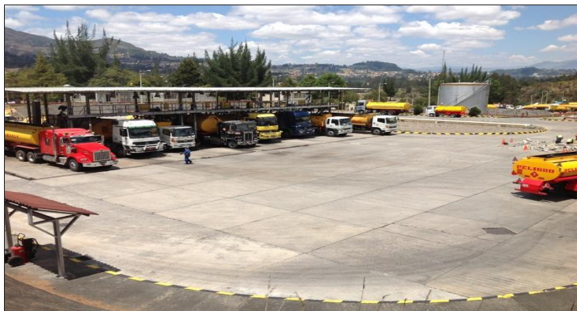
Fig. 2.8 Vista interna de Petrocomercial
