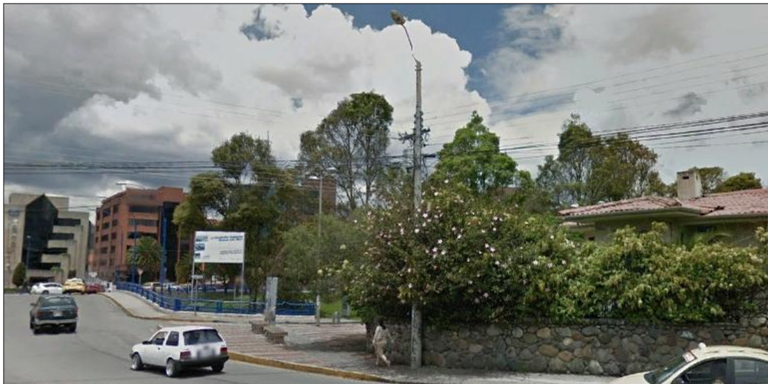
Figura 3.144 Nuevo poste para la antena del Reconnector 3.
