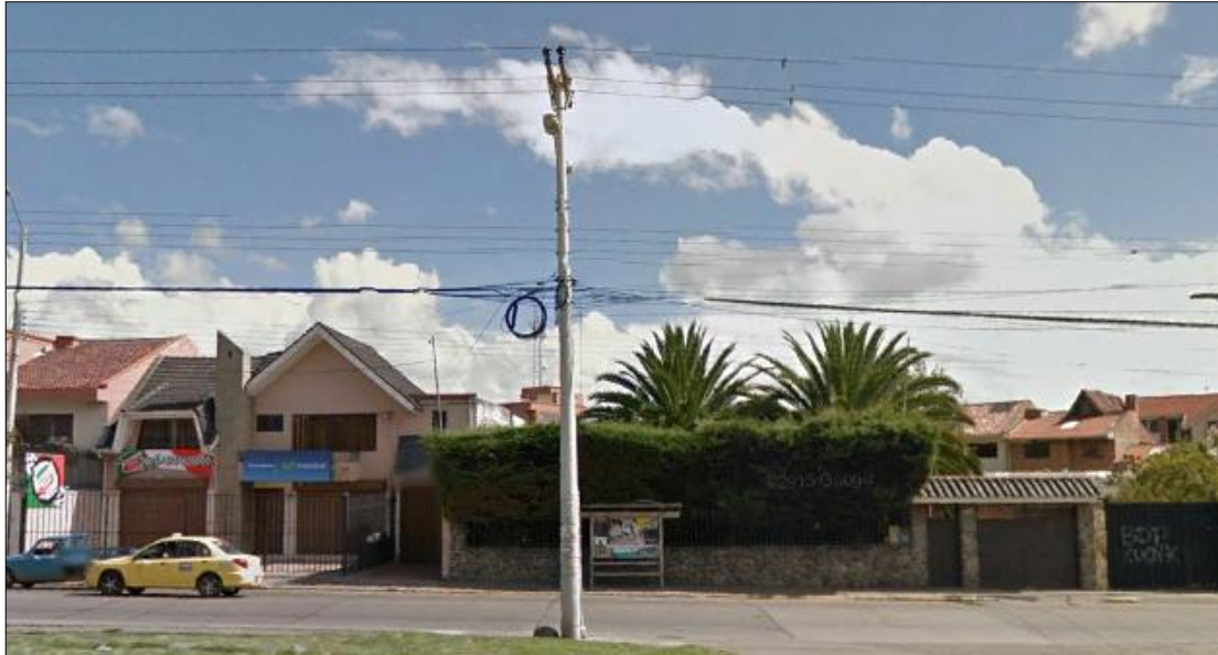
Figura 3.49 Nuevo poste para la antena del Reconector 38.
