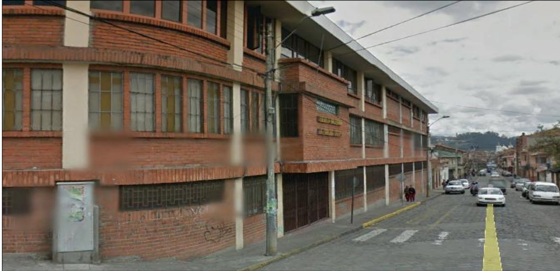
Figura 3.21 Nuevo poste para el Reconector 2.
