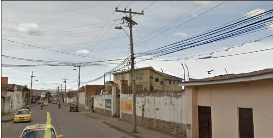
Figura 3.173 Nuevo poste para la antena del Reconector 22.
