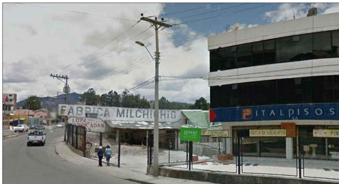
Figura 3.157 Nuevo poste para la antena del Reconector 15.
