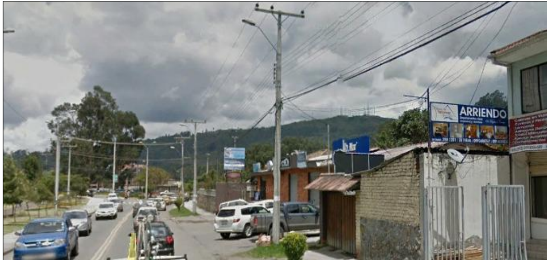
Figura 3.150 Nuevo poste para la antena del Reconector 36.
