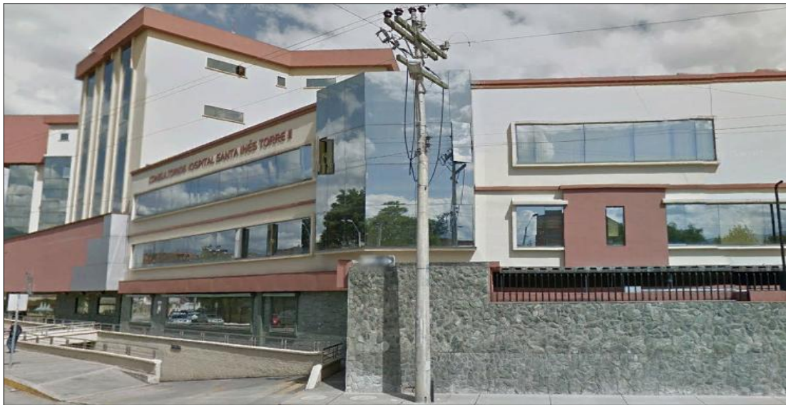
Figura 3.45 Nuevo poste para el Reconector 4.
