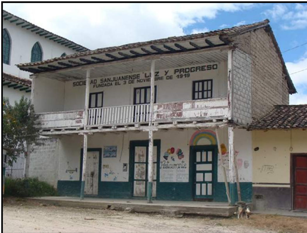
Casa Tradicional en proceso de Restauración.
