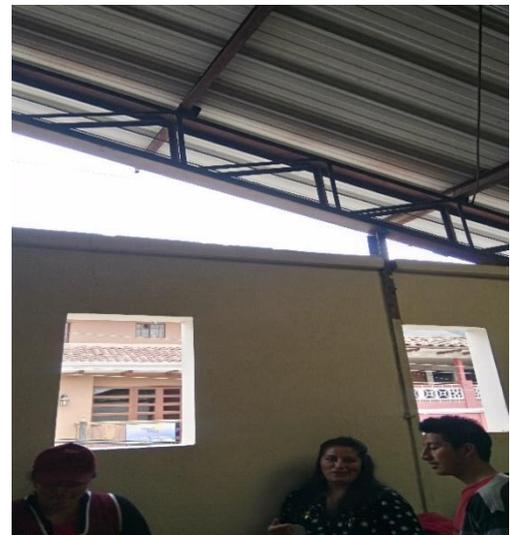
Como se observa en las fotografías adjuntas, se evidencia la presencia de espacios entre techos y paredes, así como también en las estructuras metálicas de los techos; los cuales sirven de refugio de palomas.
