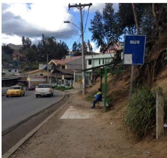
*Ilustración 14 No existe Señalización Horizontal*
