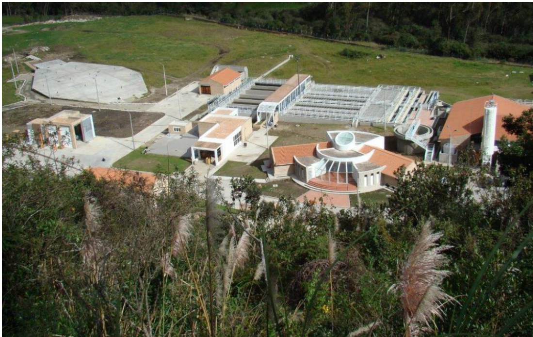
Gráfico 1.1 Planta de Tratamiento de Agua Potable de Sustag.
