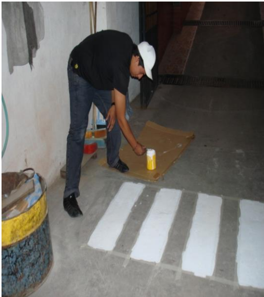
Ilustración 35: Paso peatonal Fuente: Tamara Pauta
