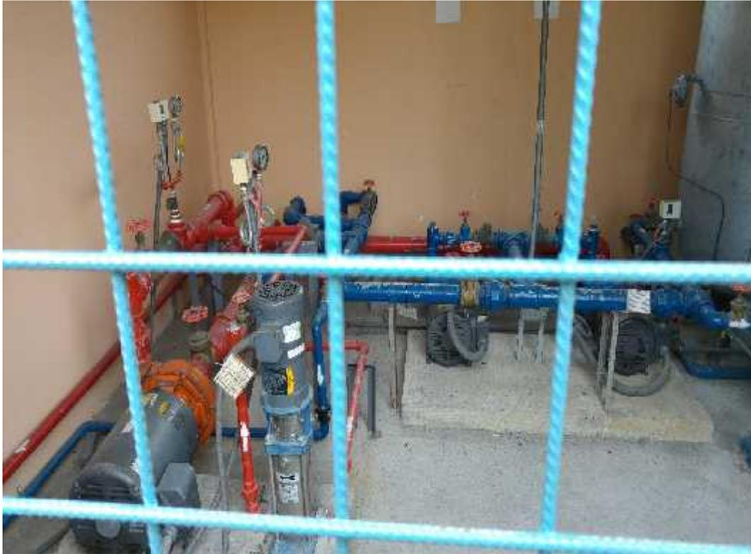
Figura 2-21: Sistema de distribución gases medicinales
