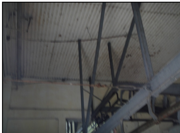
Fotografía 3 - 15: Estado actual del techo.
