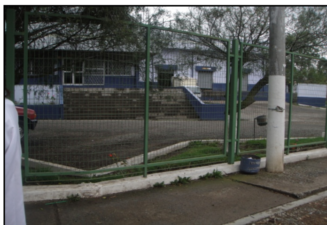
Fotografía 3 - 9: Vista frontal del camal.
