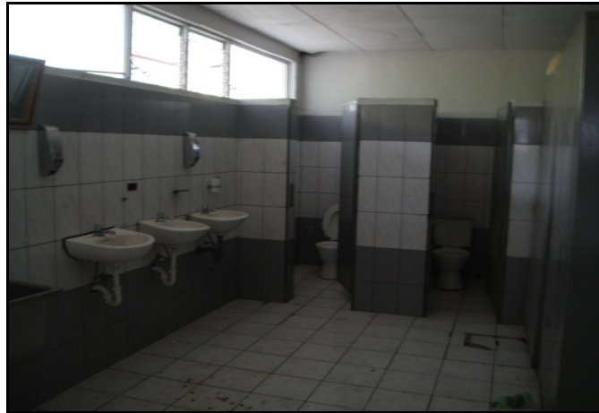
Fotografía 3 - 22: Situación actual de los baños.
