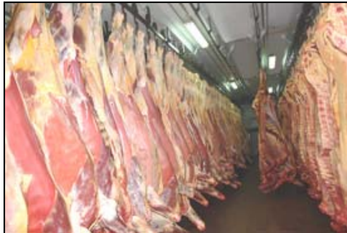
Fotografía 5 - 11: Cuarto de refrigeración.
