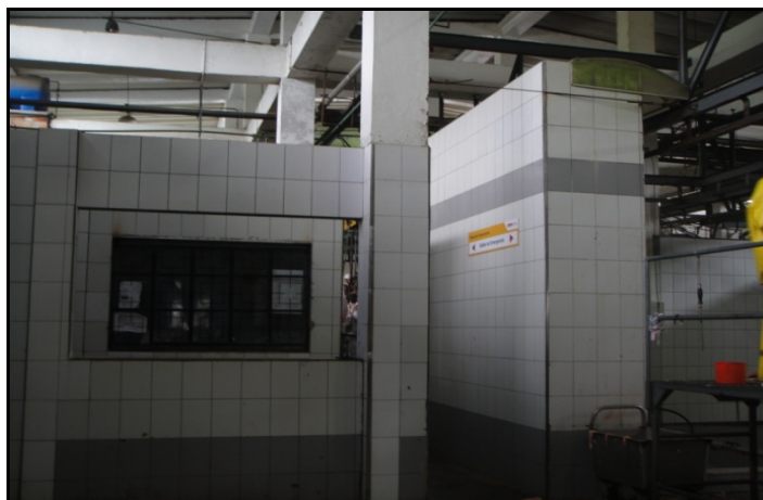
Fotografía 3 - 13 Paredes internas del área de faenamiento.
