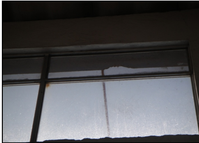
Fotografía 3 - 16: Ventanas sin protección.
