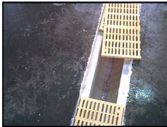
Fotografía 5 - 7: Protección de desagües.
