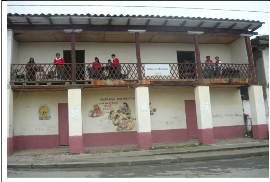
Fotografía 2.1: Local de la Biblioteca Municipal de Paccha
