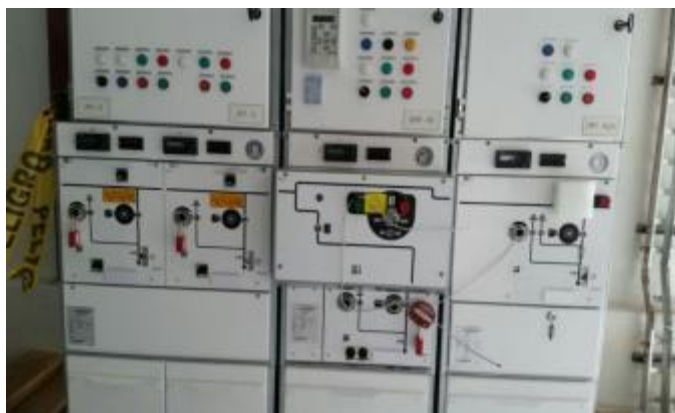
Candados en transformador de media tensión
