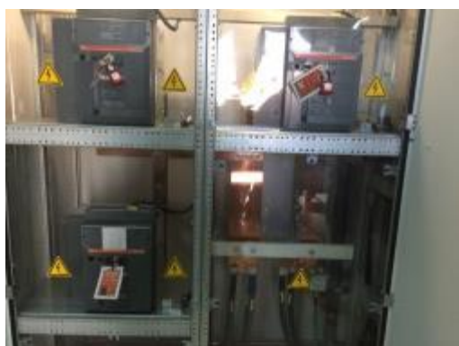
Bloqueo y etiquetado (candados y tarjetas)
