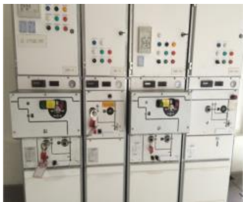
Candados en transformador de media tensión
