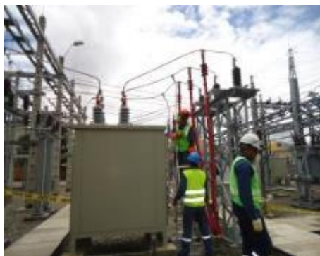
Uso de la puesta a tierra trifásica en EERCS 4
