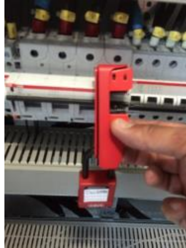
Uso de pestillo para consignación de interruptores
