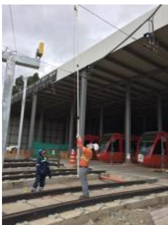
Detección de tensión en la línea aérea de contacto (LAC)
