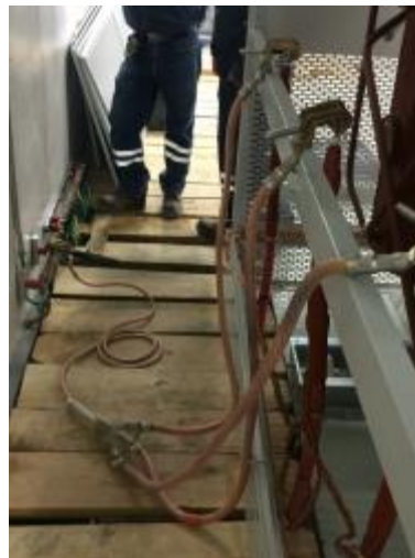
Uso de la puesta a tierra trifásica en la SE-3
