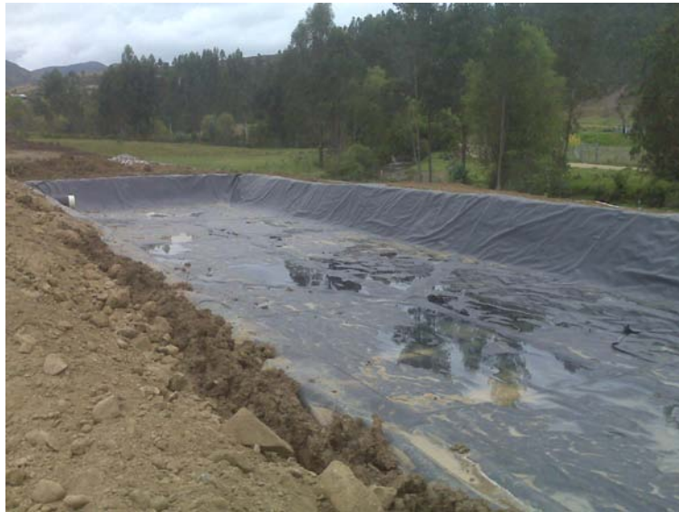
Pozos para Lixiviados
