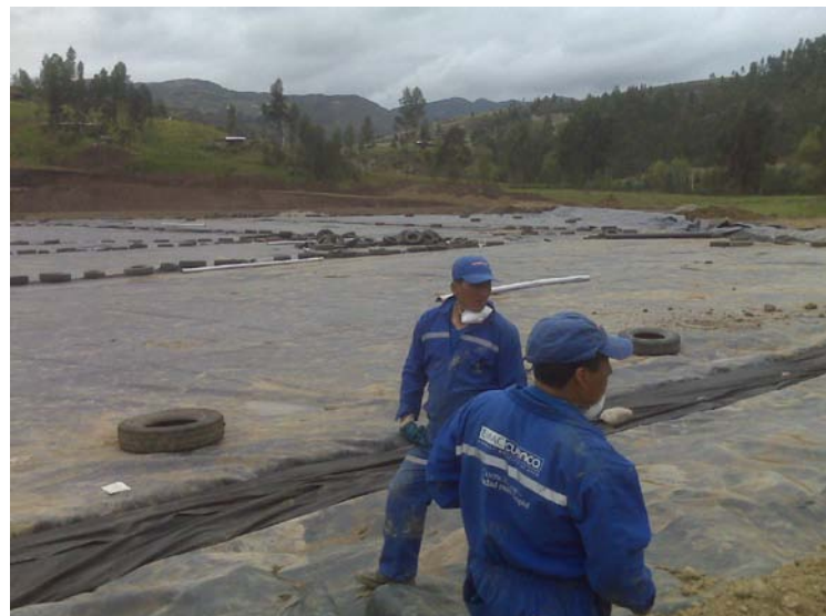
Cubierta de geomenbrana
