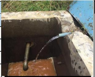
Finalmente se realizó aforos en un tanque común de la tubería proveniente de las tres captaciones más el aporte de una quebrada, obteniendo los siguientes resultados:
