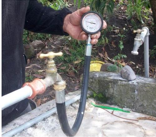
Figura 1.18 Toma de Presiones con un Manómetro
