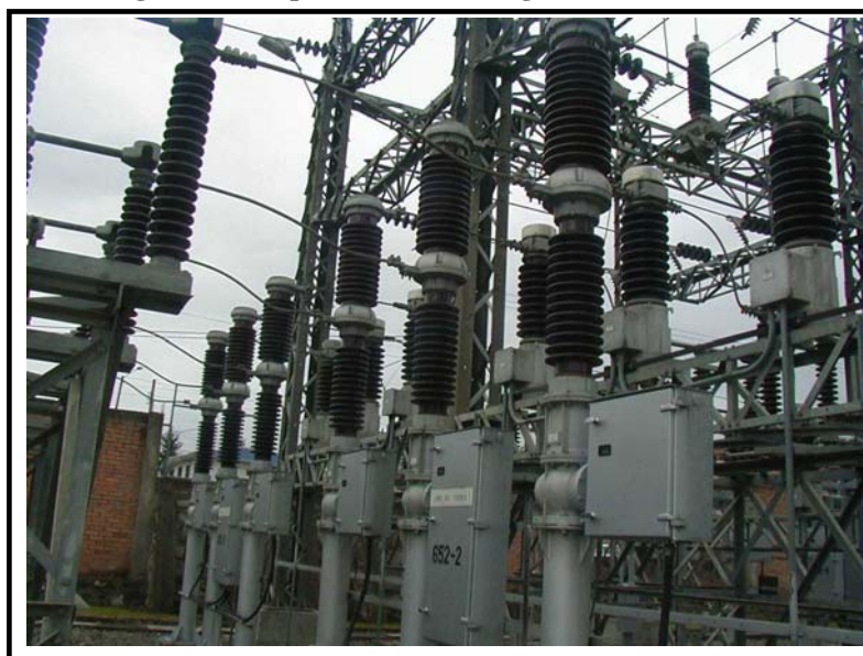
Fotografía 2. Empresa Eléctrica Regional Centro Sur C.A.
