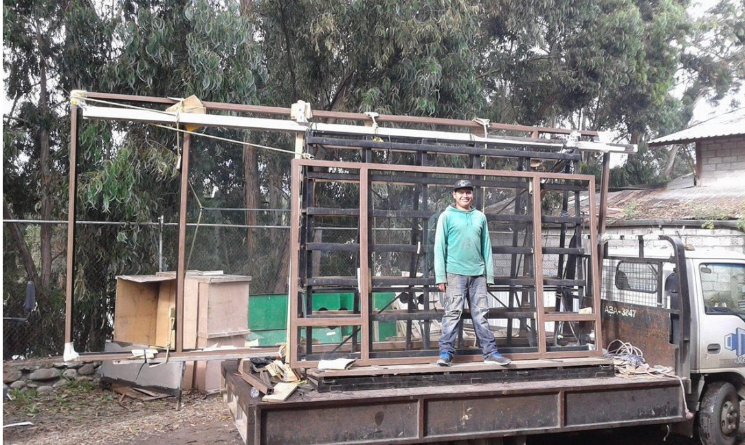
Obra lista para instalación 1
