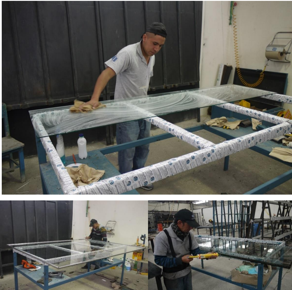
Figura 1.17: Armado de cámaras
