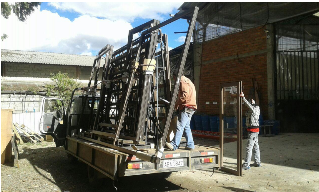
Obra lista para instalación 2
