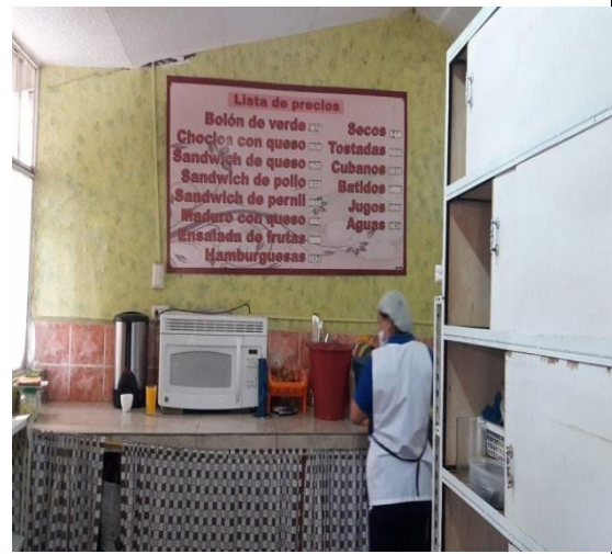
Paredes, techo, mesones del local.
