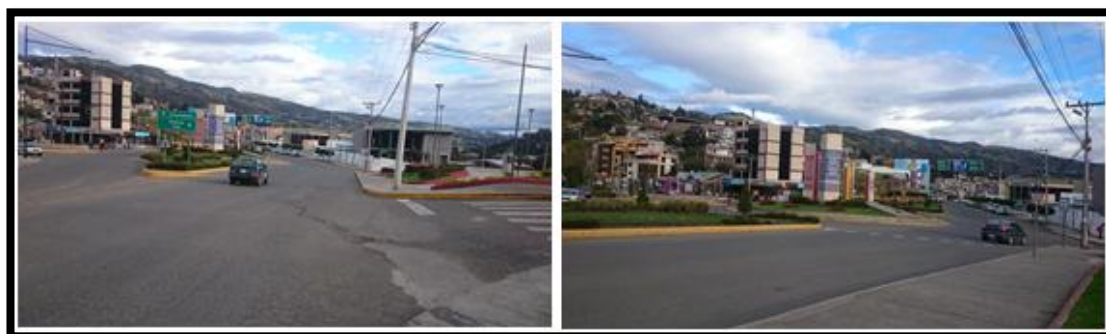
Figura 3.15: Fotografía km 61+770 – 61+900. Fuente: Autora
