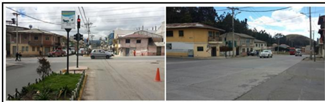
Figura 3.10: Intersección km 26+750-26+850. Fuente: Autora
