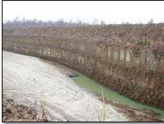
Figura 1.4. Mina en donde se explotó por el método de contorno.
