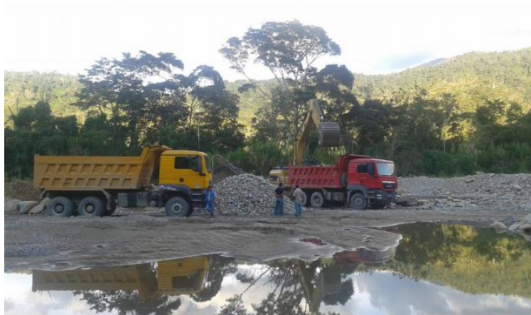
Figura 2.6. Zona donde se va hacer la excavación de los noques Fuente: (ESI, 2015)
