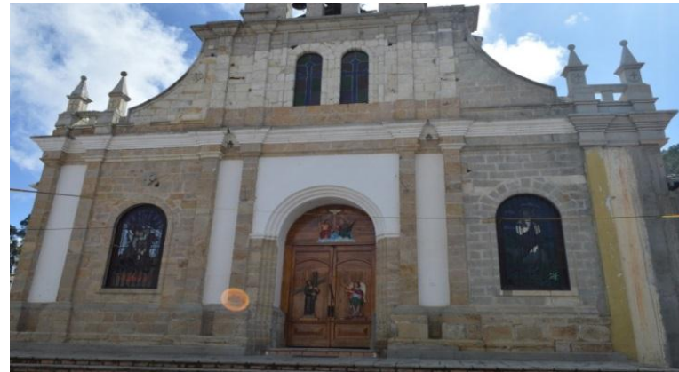
6 – 002 Fachada de la Iglesia San Miguel de Porotos
