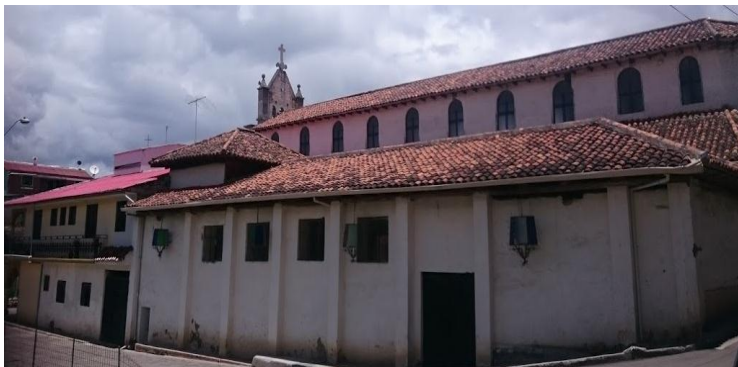
6 – 002 Parte posterior de la iglesia San Miguel de Porotos
