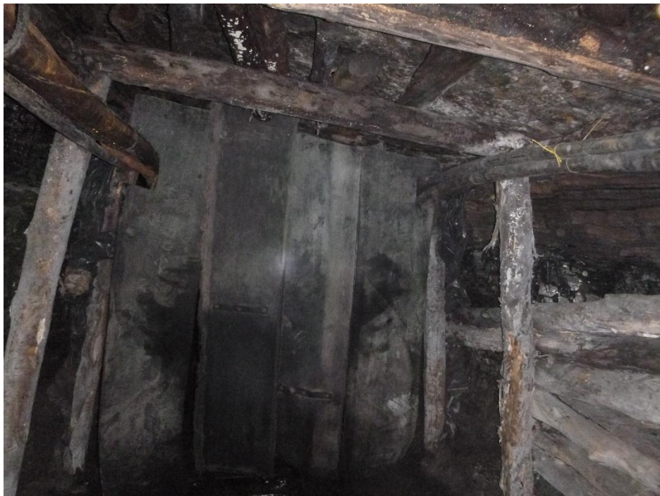
Anexo 6. Cortinas de banda clavada del 34 mina El Bloque Fuente: Ing. Alan Daza.
