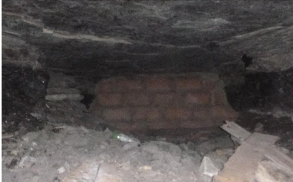
Anexo 5. Tapón en frentes ya explotados, estableciendo el circuito de ventilación Fuente: Ing. Alan Daza.
