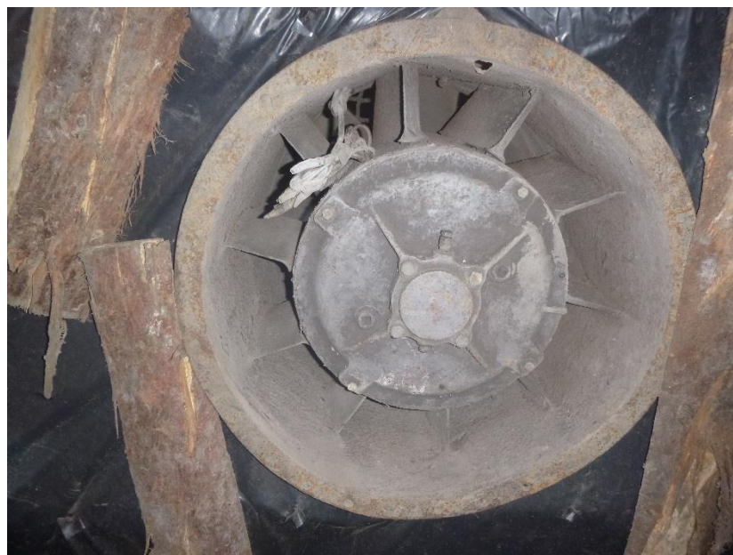
Anexo 2. Ventilador secundario a succión de tipo axial de 7 [HP] Fuente: Ing. Alan Daza.
