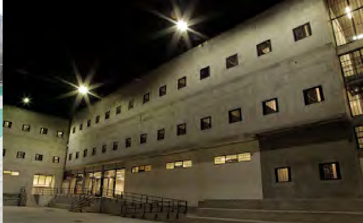
Imagen 45. Exterior visto desde patio en CRS de Turi
