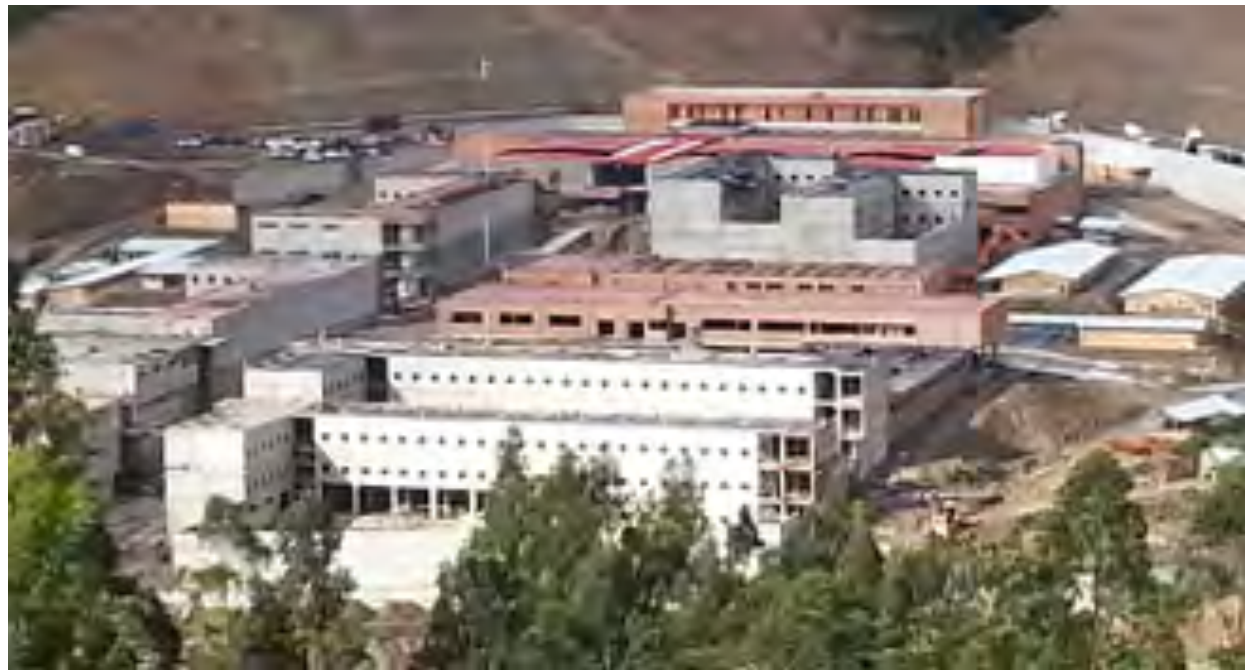
Imagen 4. Vista posterior centro de rehabilitación social de Turi
