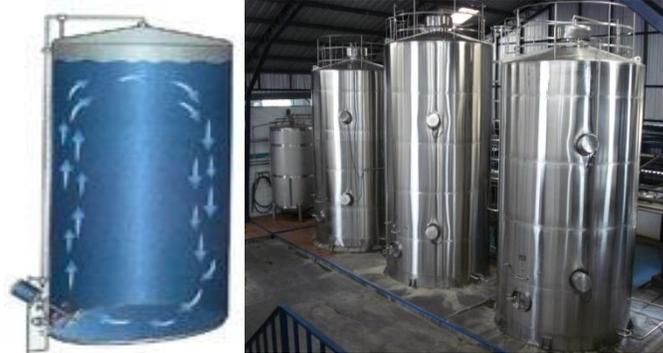
**Figura 3.** Tanque de almacenamiento de la materia prima
