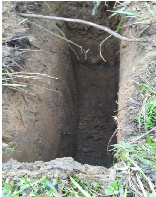
Figura 3.8 Calicata de exploración elaborada
