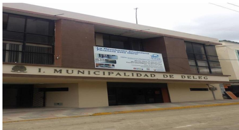
Figura 1. Edificio del Gobierno Autónomo Descentralizado Municipal de Déleg.
