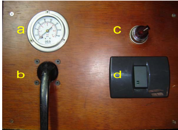
Fotografía 4-7. Tablero de control
