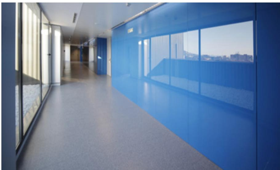
Figura 25: Pared revestimiento de vidrio
