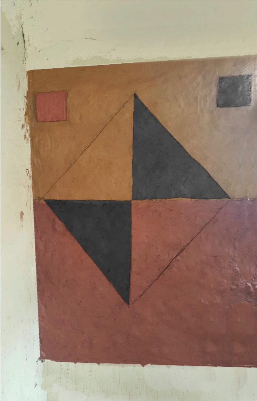
Fig.96: Aplicación final de revoques en base a trama y corrección del perímetro con mortero de cemento
