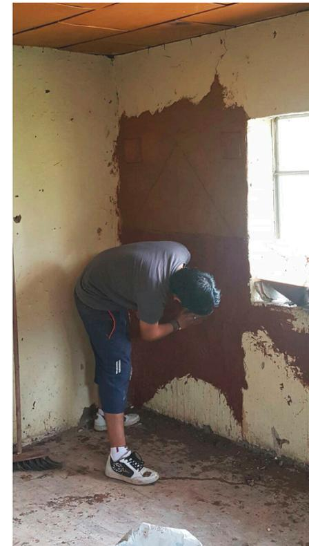
Fig.92: Aplicación de las mezclas en pared de adobe
