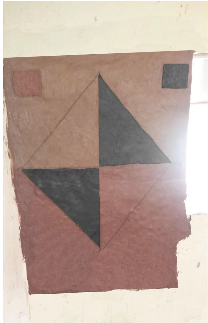
Fig.97: Aplicación final de revoques en base a trama y corrección del perímetro con mortero de cemento
