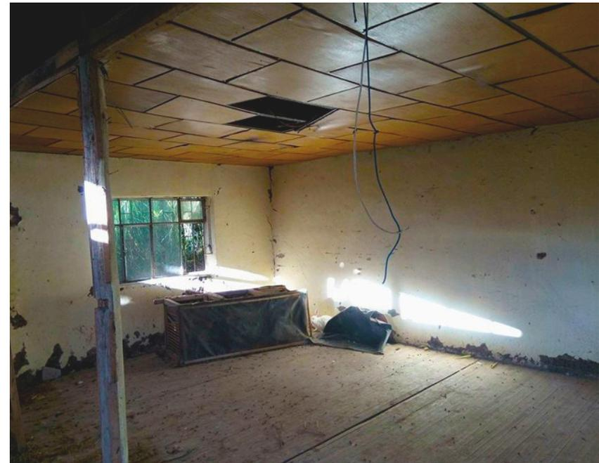
Fig.71 Estado del espacio interior evidentemente deteriorado la mampostería
