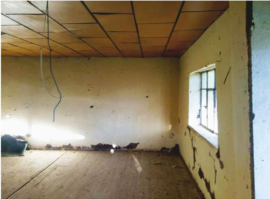
Fig.70 Estado del espacio interior evidentemente deteriorado la mampostería
