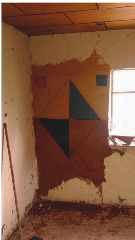
Fig.94: Aplicación de 3 mezclas de revoque: naranja, roja y negra
