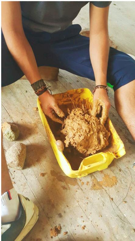
Fig.91: Preparación de la mezcla (dosificación "J")
