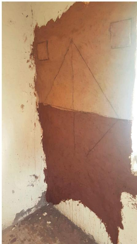
Fig.93: Aplicación de 2 mezclas de revoque naranja y roja
