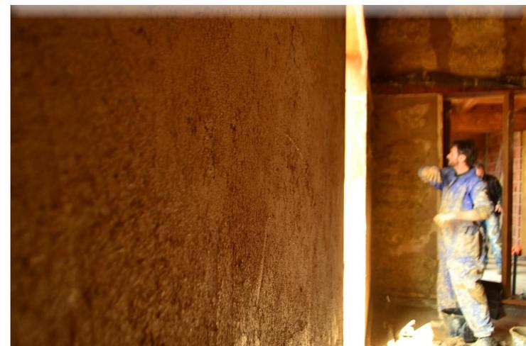
Fig.20 Aplicación de revoque de tierra imagen tomada de: <http://siendotierra.blogspot.com/2017/04/>
