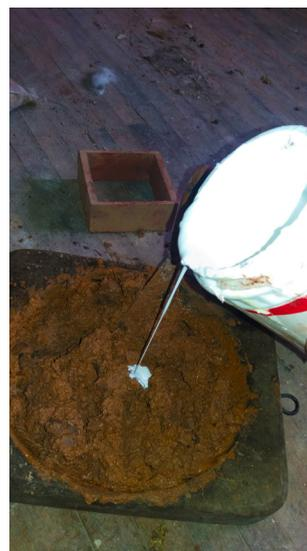
Fig.53 Aplicación de resina vinil acrílica en mezcla
