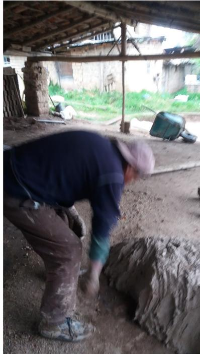
Fig.27 Preparación de la mezcla de barro, como se ve en la imagen se la deja la masa en reposo varias horas antes de usarla esto para que se evapore un poco el agua haciendo que la mezcla sea más pegajosa
