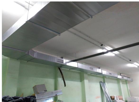
Mecanismo de ventilación eólica, que funciona mediante un sistema de extractores eólicos, los ductos son empleados para la recirculación o distribución del aire en todo el interior, el aire renovado se disipa por el local mediante las rejillas de ventilación desplegadas por todo el cielo raso.
