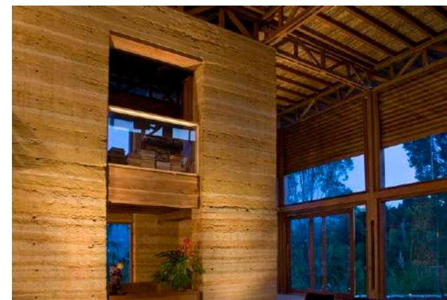
Imágen: Fundación Tierra Viva. Muros de Tapial en interiores
