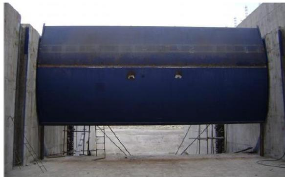
Figura 1. 4. Compuerta radial
