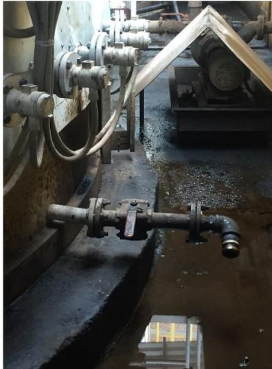
**Fig. 2-10 Purga agua tanque principal**
