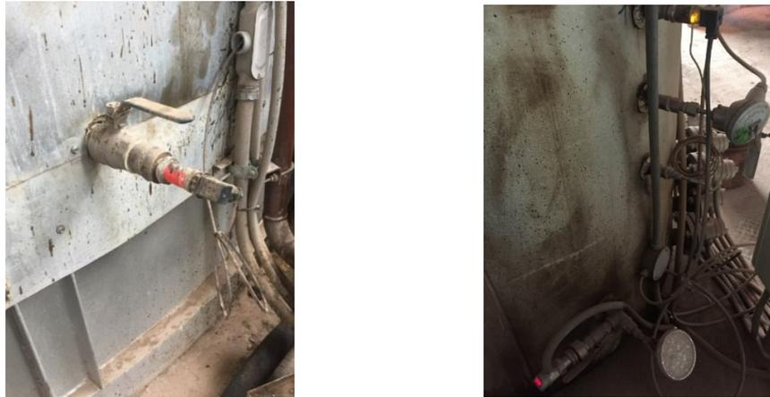
**Fig. 2-11 Sensores de Nivel**
