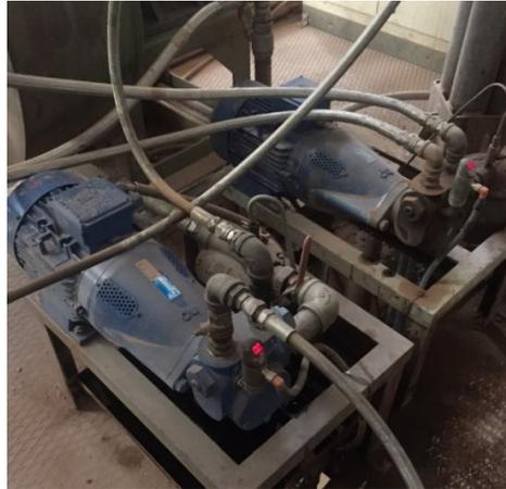
**Fig. 2-4 Bomba quemador**
