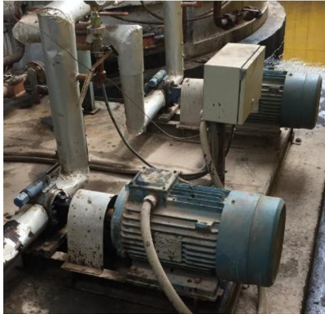
**Fig. 2-2 Bombas Tanque Principal hasta Tanque diario**
