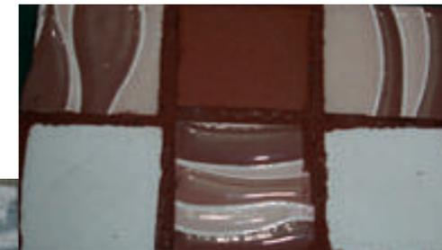
Dentro de este módulo se encuentran tres tipos de recortes de baldosas, dos lisos y uno en relieve; los mismos que tienen una base de hormigón y empujan en las uniones de las baldosas
