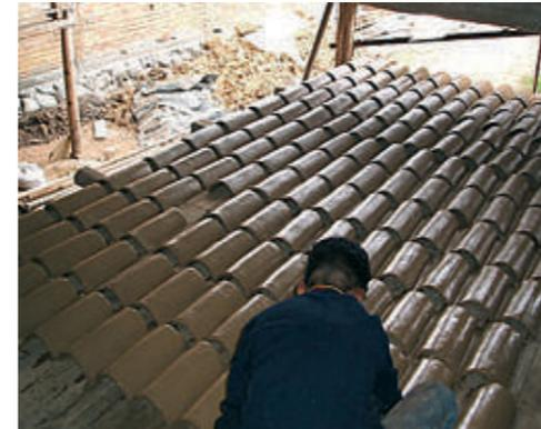
Por lo general para la fabricación de las tejas se utiliza el método artesanal y para los ladrillos la técnica semi industrial
