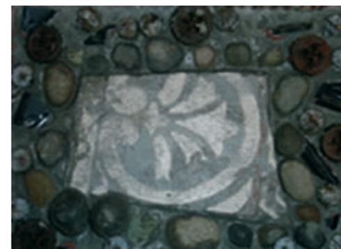
Para esta propuesta se utilizó recortes de tres diferentes baldosas, al igual que en la propuesta anterior; con base de hormigón y para las uniones entre sí, se aplicó piedra y arena volcánica
