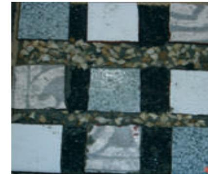
Para este módulo se utilizó recortes de tres diferentes baldosas, al igual que en la propuesta anterior; con base de hormigón y para las uniones entre sí, se aplicó piedra y arena volcánica
