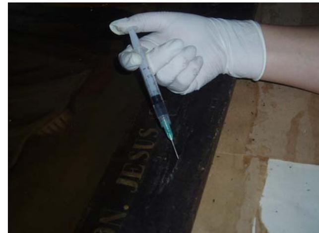
Foto N. 17 Desmontaje con infiltraciones
