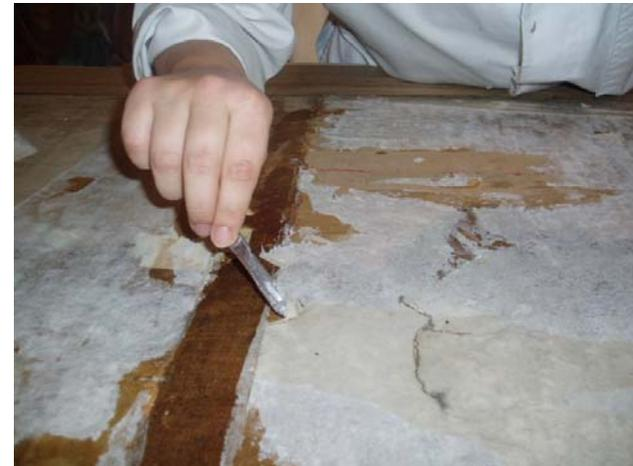
Foto N 55 Eliminación de elementos extraños. Mecánica
