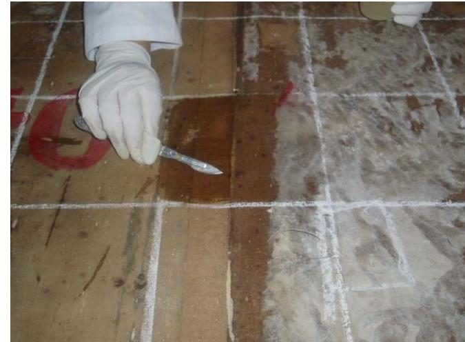
Foto N. 29 Limpieza mecánica química con metilcelulosa
