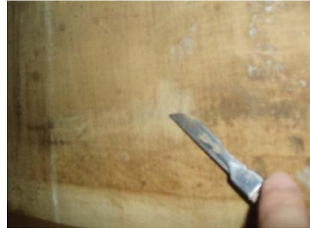
Foto N. 28 Limpieza mecánica con bisturí
