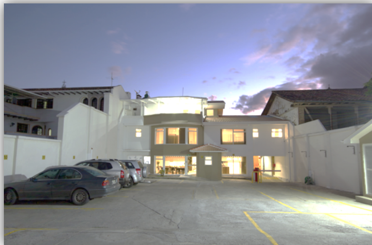
Ilustración 15 Instalaciones Suites, San Blas Suites
