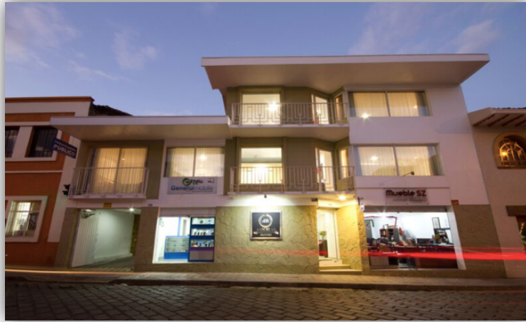
Ilustración 13 Instalaciones Suites, San Blas Suites
