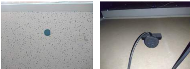
(a) Cámara instalada, vista frontal. (b) Cámara instalada, vista posterior
