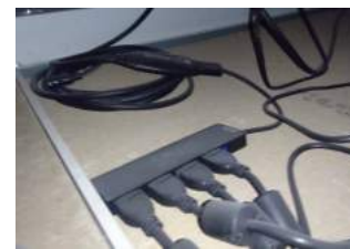
(c) Conexión de los HUBs y las cámaras
