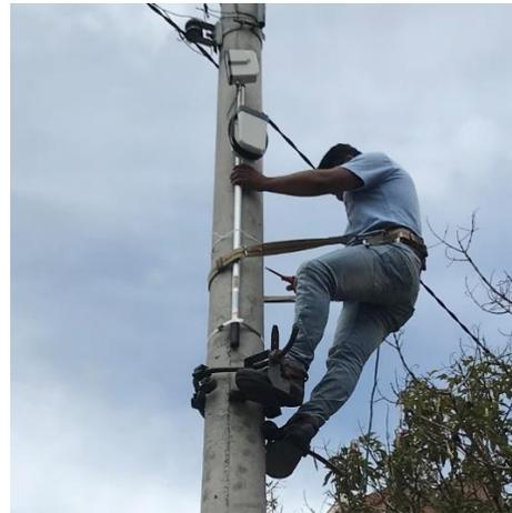
Figura 3.18: Instalación de las cámaras de conteo de tráfico
